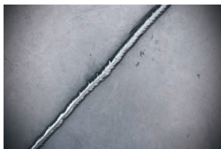
Junta de soldadura
