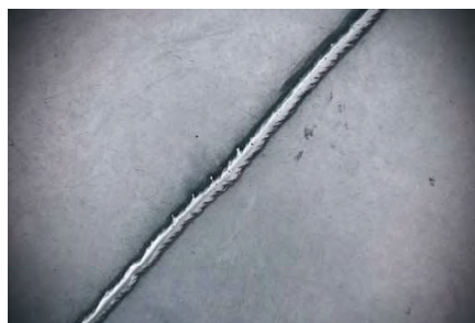
Juntas de soldadura
