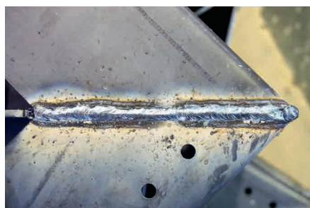
Lijado de juntas de soldadura
