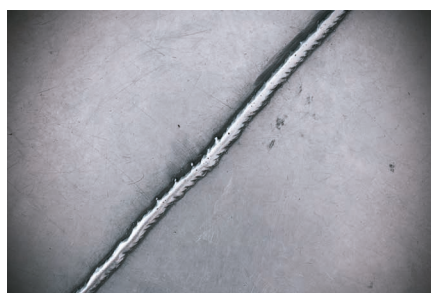
Juntas de soldadura
