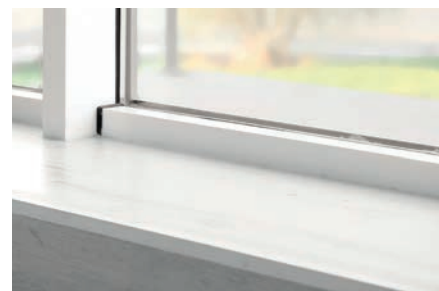
Peitoril de janela e degraus de granito Tratamento de bordas
