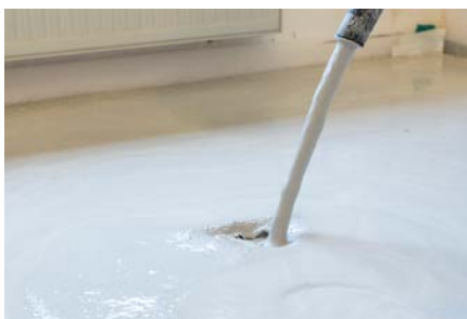
Camada de anidrite | Lixagem plana
