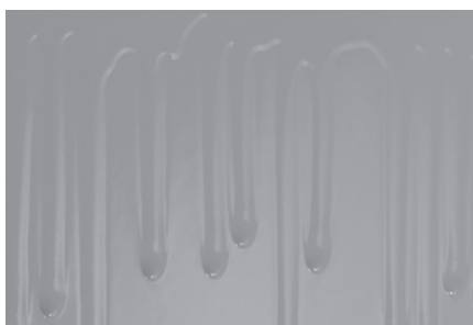
Eliminação de escorridos
