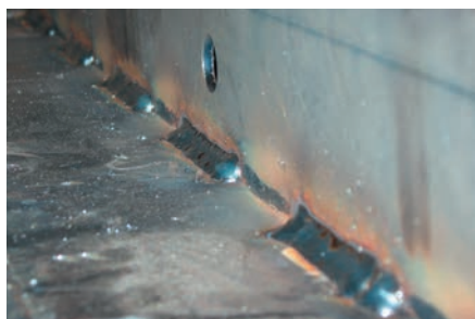
Tratamento de soldaduras angulares
