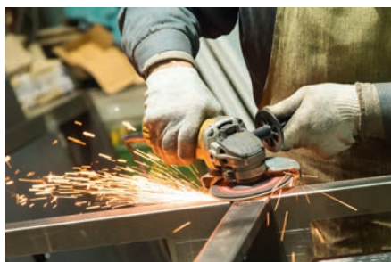
Tratamento de juntas de soldadura em geral
